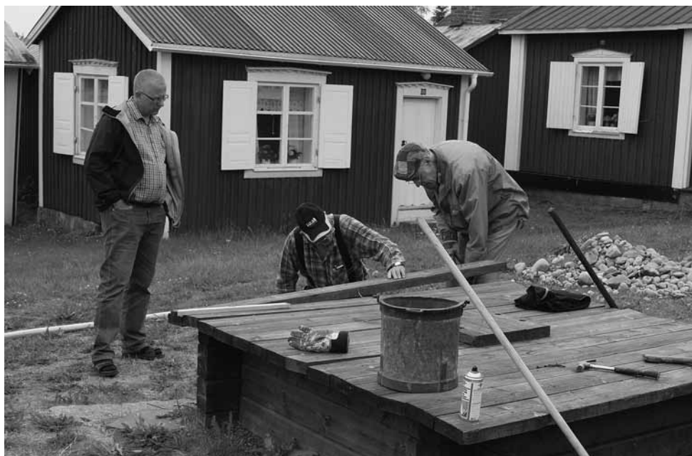
Det gamla brunnslöcket fanns kvar men behövdes repareras. Här Jan Bramberg och Bengt Johansson i full färd med fundamentet till brunnshäverten och stående Bengt Ersson. Foto: Ove Johansson.
