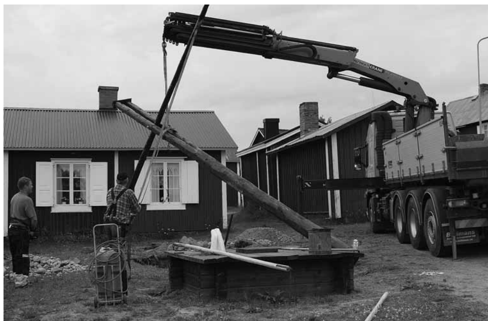
Så var det dax för resningen och med hjälp av en lastbilskran fick man brunnshäverten på plats. Foto: Ove Johansson.
